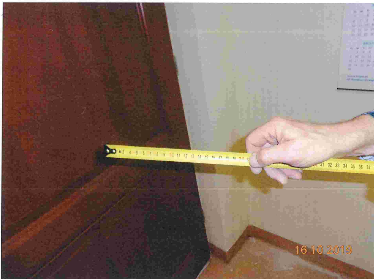
Fot. Nr 4 Pomiar grubości ściany działowej w miejscu przebicia - 21 cm
